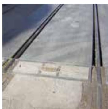
Sistema di pesatura per vagoni ferroviari in acciaio verniciato su cui sono fissati i binari di corsa tipo 50/60 UNI
