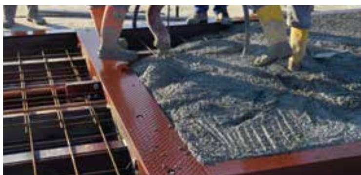
Pesa a ponte realizzata in versione ferro-cemento.
