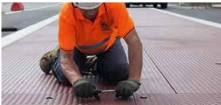
Pesa a ponte in acciaio verniciato con celle digitali o analogiche con botole trasversali per accedere alle celle di carico.
